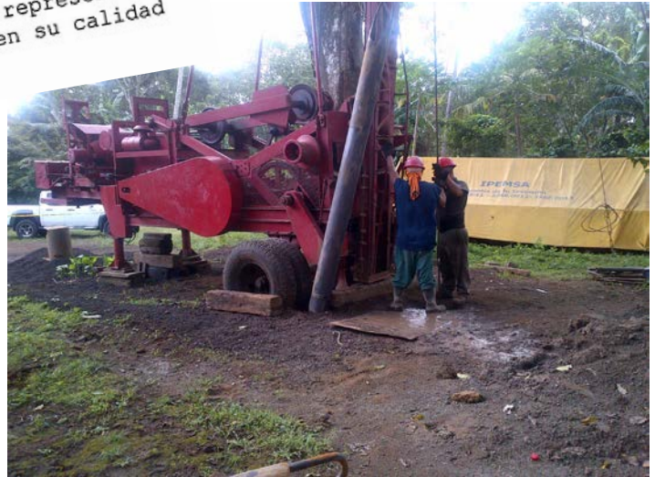
Immagine 3: Lavori di perforazione
