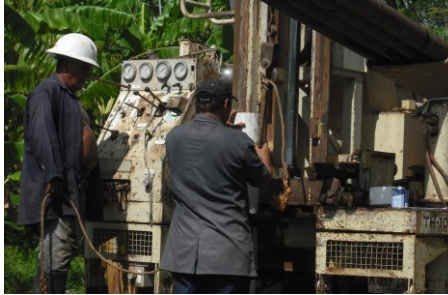
Trivellazione e prova del flusso di acqua per il secondo Pozzo
