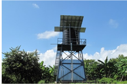
Torre 1 con impianto solare
