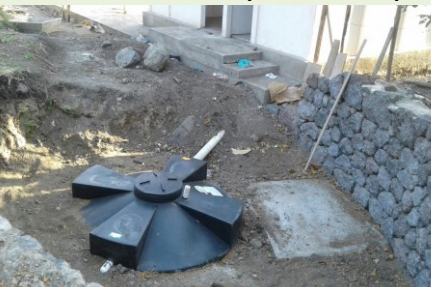
Per i servizi del nuovo Centro sociale è stato utilizzato il sistema "Bio-digestor"
