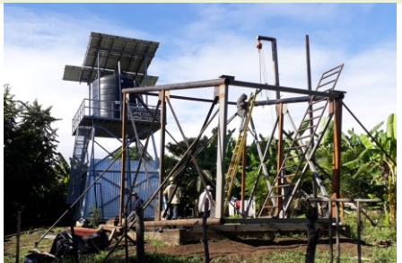
Costruzione Torre 2 e posa del tank
